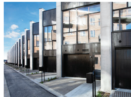
KRONE har bygget de store dobbelte vindueskarme og benyttet genbrugsglas fra nedbrudte bygninger i Nordjylland til arkitektfirmaet Lendager Groups' Upcycling Studios i København.
